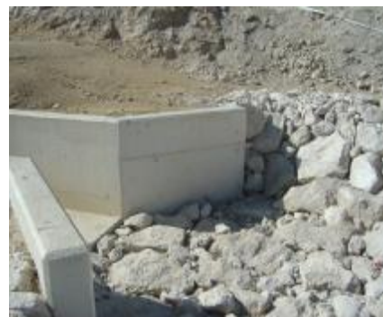
Escollera de protección
