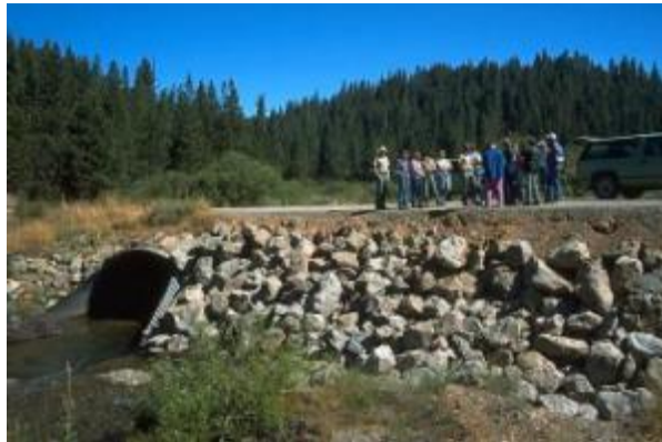
Obra de drenaje con un arco de acero corrugado y protección de escollera con geotextil aguas abajo.
