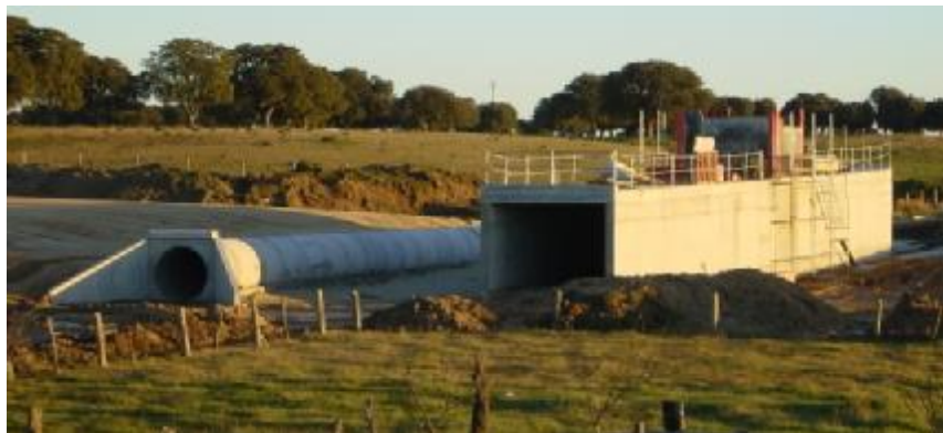
Obra de drenaje transversal junto a paso inferior en la Autovía de Castilla durante su construcción
