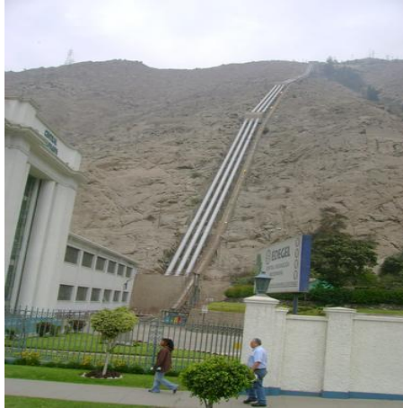
Fig N°7.6 se muestra la tubería forzada de la CH de Huampani - Chosica.
