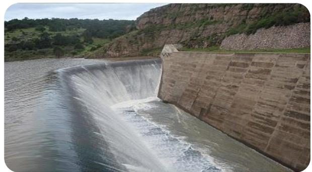
Figura 3. Vertedor de cimacio con canal lateral.
