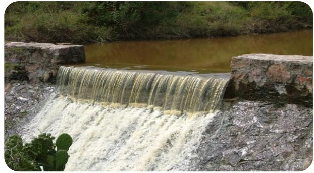
Figura 2. Vertedor de caída recta y descarga directa.
