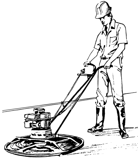
Fig. 7 Alisado mecánico utilizando el "helicóptero".
