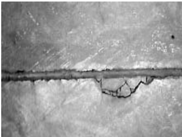
Fig. 9 Desastillado de los bordes de la losa
