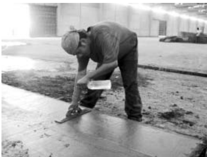
Fig. 10 Operación incorrecta. no debe agregarle agua a la superficie
