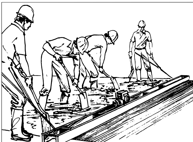
Fig. 4 Los codales vibratorios ó de madera se utilizan para nivelar la superficie del concreto
