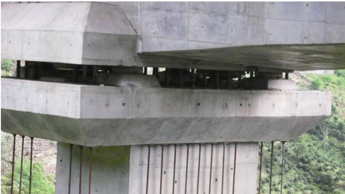
Figura 6. Aislador Puente La Estampilla
