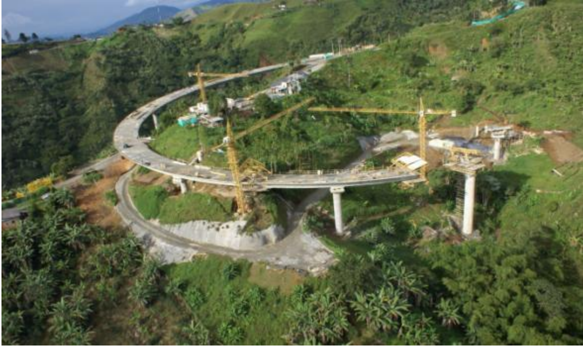
Figura 3. Viaducto El Helicoidal
