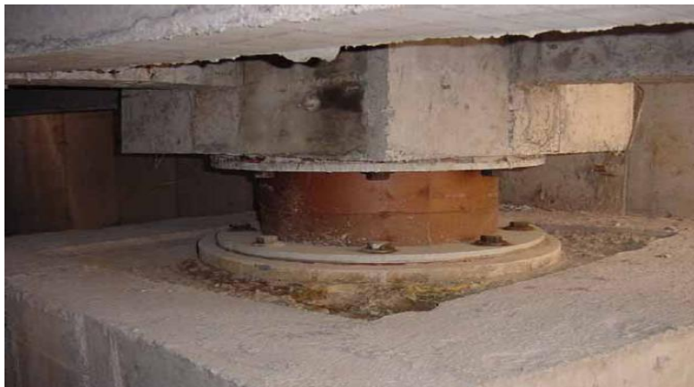
Figura 18. Apoyo elastomérico
