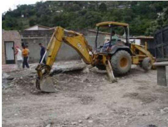
Figura 1 _ Limpieza del terreno
