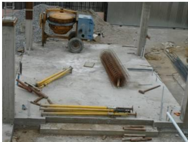
Figura 2 _ Materiales, herramientas y maquinaria en obra.
