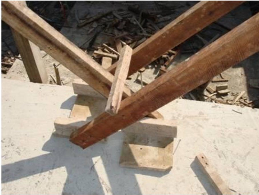
Figura 5 _ Anclaje de puntales de madera diagonales en el nivel inferior
