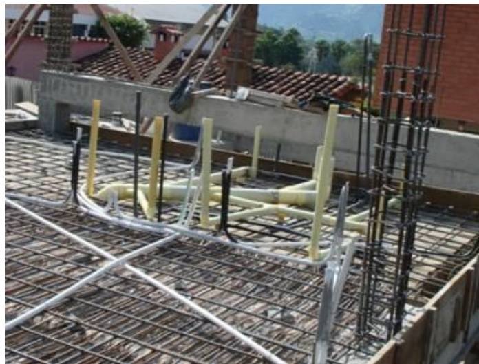
Figura 8 _ Instalaciones eléctricas e hidrosanitarias en losa maciza
