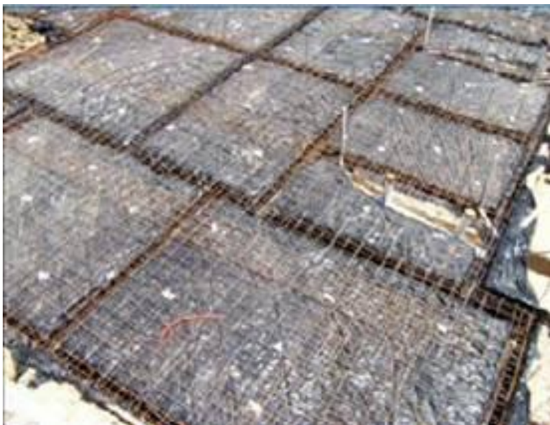
Figura 10 _ Malla electrosoldada colocada en losa maciza
