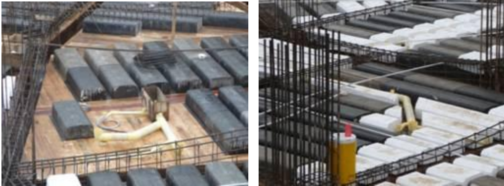
Figura 9 _ Instalaciones eléctricas e hidrosanitarias en losa nervada.
