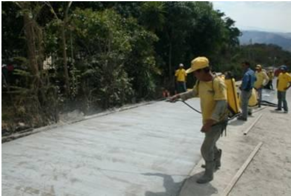
Figura 11 _ Curado de losa de entepiso
