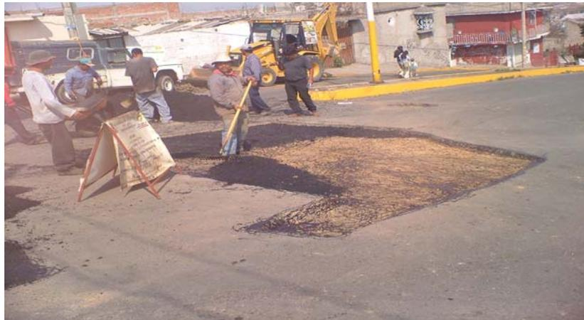
**Fig. 5.1.1 Reparación de un bache**
