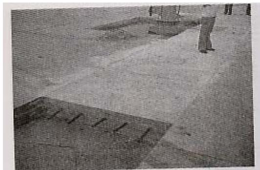
**Fig. 4.2.4** Pasa juntas de transferencia de cargas en el pavimento durante en la rehabilitación.
