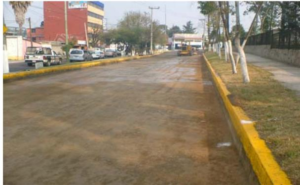
**Fig. 1.3.2** fotografía de una base bien compactada y terminada.
