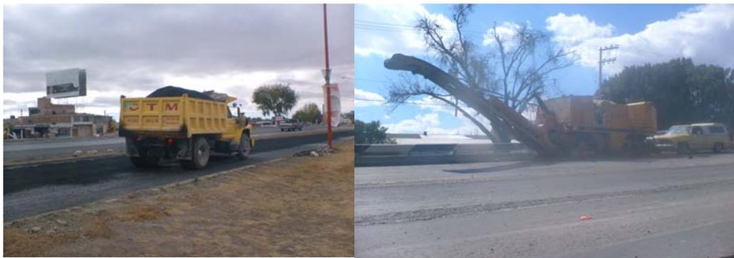
Fig. 6.5.1 Recuperadora de asfalto y transportada a la planta de reciclado.
