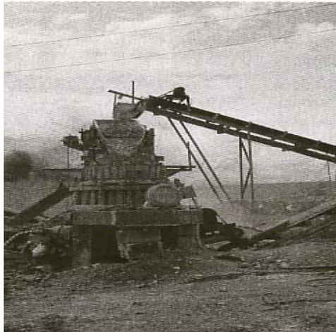
**Fig. 1.3.4.** Planta de trituración para el material pétreo que se utilizará en carpetas de concreto asfáltico.
