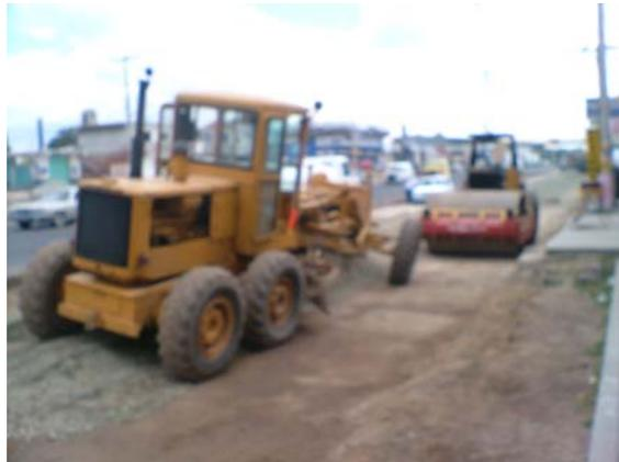
**Fig. 1.3.3** fotografía de una sub-base en proceso.
