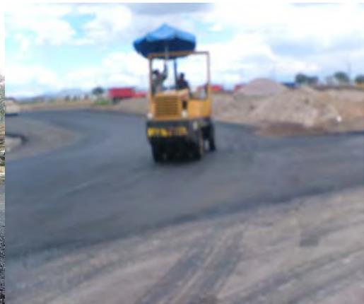
**Fig. 1.3.12. Compactación de una franja de carpeta de concreto asfáltico por medio de neumáticos (a la derecha) y rodillos lisos (a la izquierda)**
