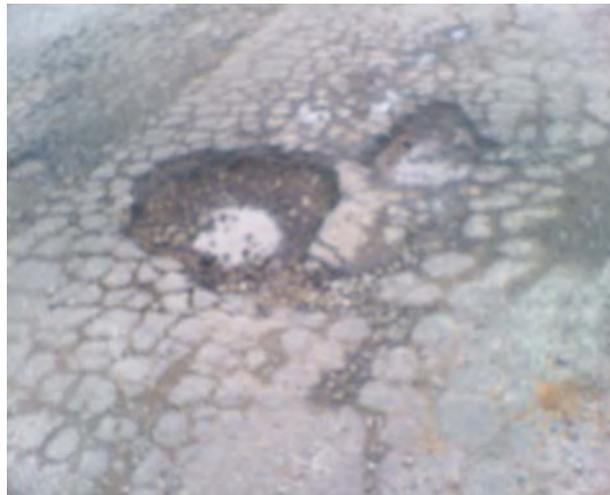
**Fig. 4.1.6** Baches en la superficie de rodamiento.
