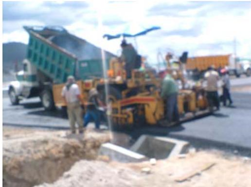
**1.3.11 Los camiones descargan el concreto asfáltico en la caja ubicada en la parte delantera de una máquina extendedora autopropulsada, que forma sobre el camino una franja de carpeta ligeramente compactada.**
