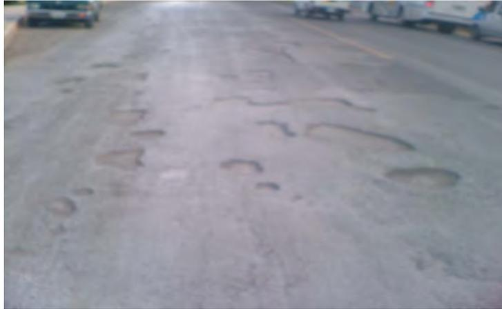
**Fig. 4.1.5** Calavereo en la superficie de rodamiento, en sobre carpetas, sobre otras agrietadas.
