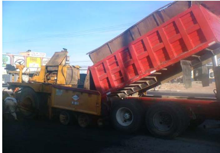
d) Inmediatamente después del terminado de la mezcla asfáltica, deberá compactarse por medio de un compactador liso; a continuación se empleará un compactador de neumáticos y por último, nuevamente el compactador liso.
