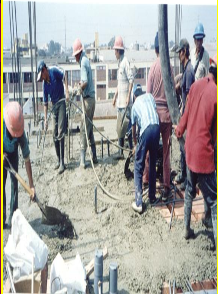
Vaceado y Vibrado de Losa
