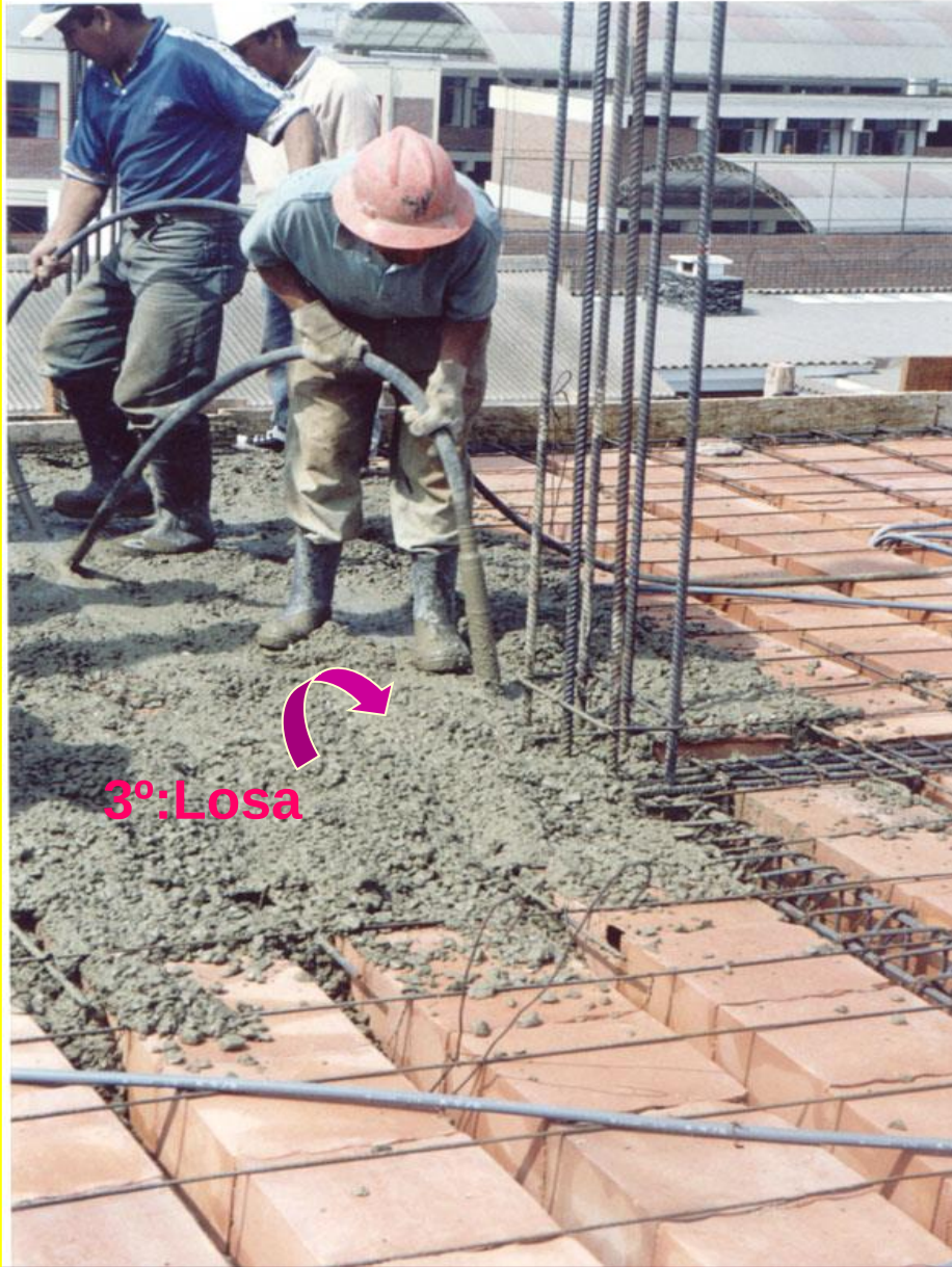
Vaceado y Vibrado de Losa
