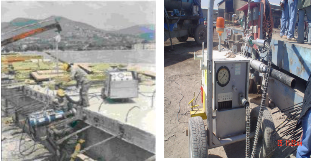
Figura 5.19 Diferentes tipos de gatos utilizados en el pretensado y postensado de piezas.
