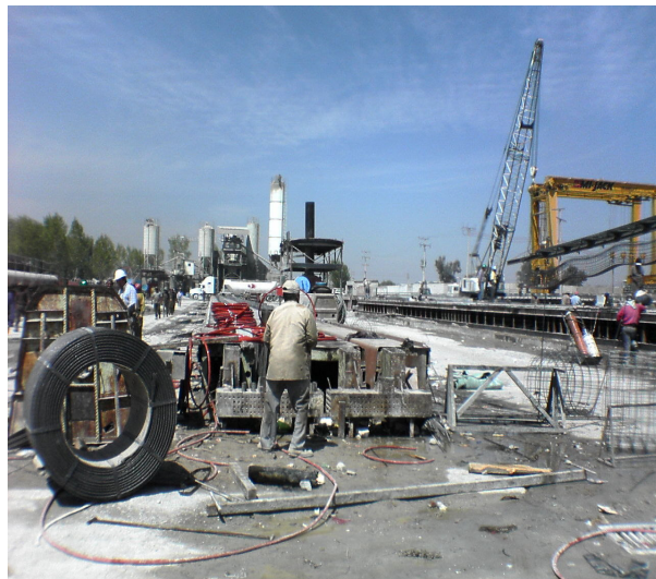
Desmolde de trabe cajón.
