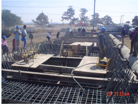
Fabricación en obra de una viga cajón con aletas pretensada de grandes dimensiones (Línea B metro de la Ciudad de México).
