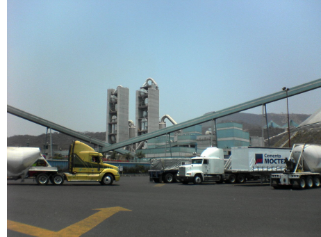
Figura 5.9 Detalle de almacenaje y transporte de cemento a granel en una planta de producción.
