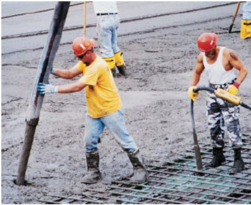
Fig. 10-15. (Izquierda) Una bomba montada sobre el camión y un aguilón pueden convenientemente mover el concreto verticalmente y horizontalmente para la posición deseada. (Derecha) Vista de la descarga del concreto de una manguera flexible conectada a la tubería rígida que se dirige de la bomba. La pipa (tubo) se usa en los aguilones de bombeo para mover el concreto hasta distancias relativamente largas. Hasta 8 m (25 pies) de manguera flexible se puede conectar a la extremidad de la tubería rígida para mejorar la movilidad de colocación.
