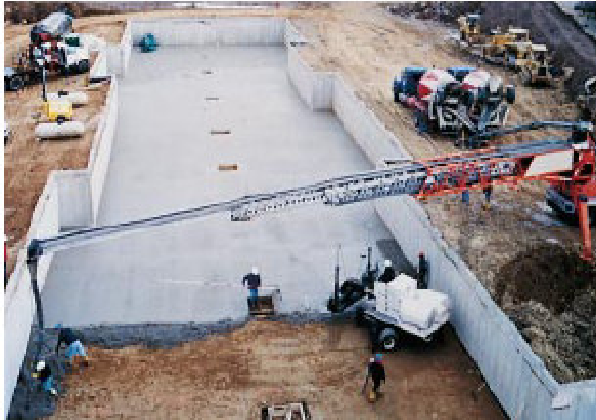
Fig. 10-13. La estera (banda) transportadora es un método eficiente y portátil para el manejo del concreto. Un canalón previene que el concreto segregue al dejar la estera. El tractor raspador previene la pérdida de mortero. Las esteras transportadoras se pueden operar en series y sobre los aguilonos extensibles (plumas telescópicas) de las grúas hidráulicas.
