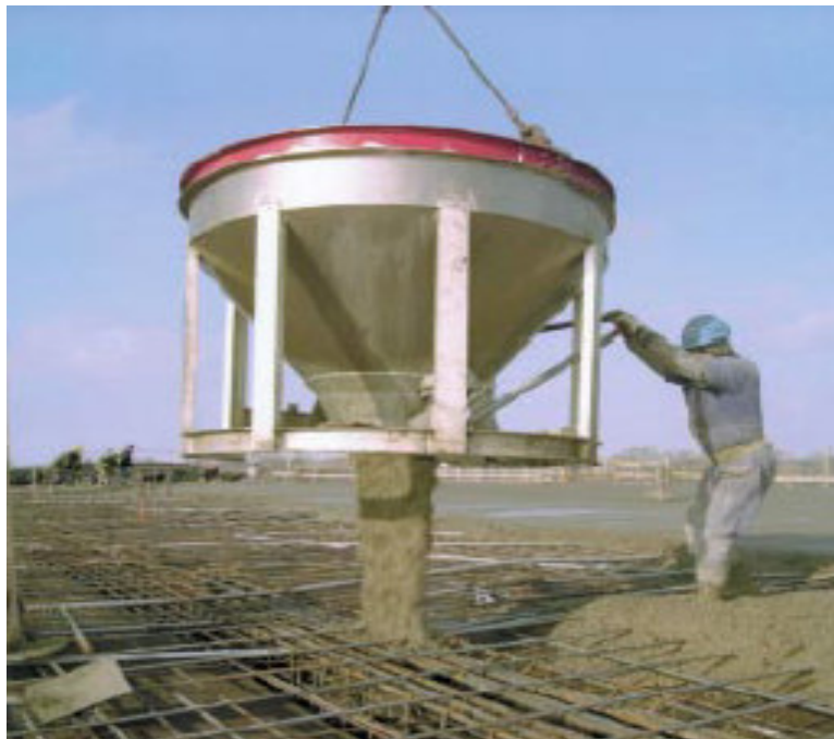
Fig. 10-9. El concreto se levanta fácilmente hacia su localización final por una grúa y cubo.
