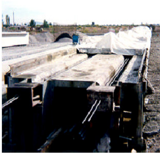
Curado con vapor de agua a alta presión.
