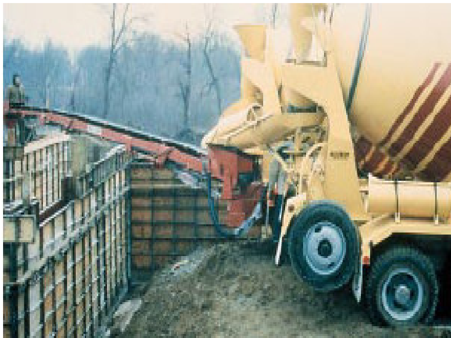
Fig. 10-14. La estera transportadora montada sobre el camión mezclador coloca el concreto hasta 12 metros (40 pies) sin la necesidad de ningún equipo adicional de manejo.
