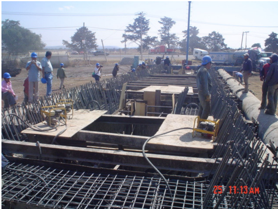
Fabricación de una viga trabe cajón (TCU) pretensada de grandes dimensiones
