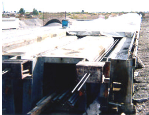
Vista de elementos curados a vapor
