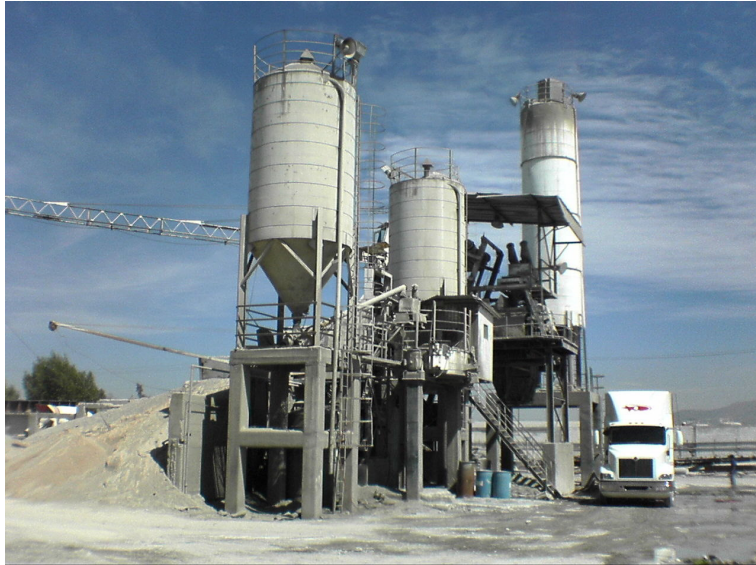
Figura 5.8 Fabricación de concreto en planta.
