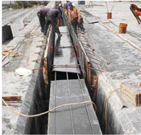
Figura 5.26 Molde de concreto para trabe cajón.
