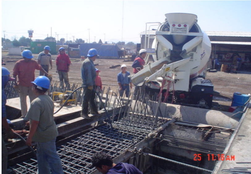
Fig. 10-10. El concreto premezclado normalmente se lo puede colocar en su localización final a través de la descarga directa por el canalón desde el camión mezclador.
