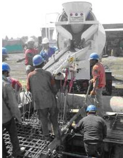
Figura 5.18 Deposito de concreto mediante revolvedora.
