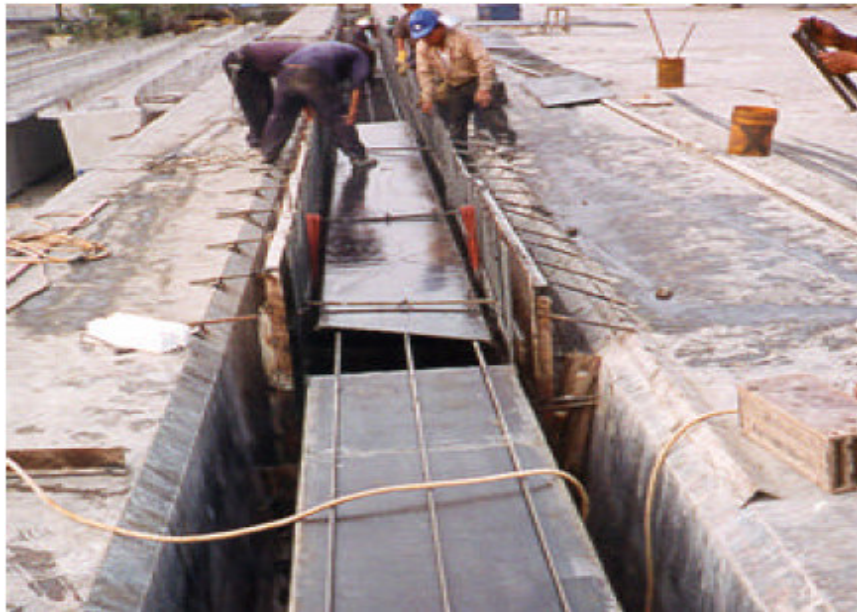
Molde de concreto para trabe cajón
