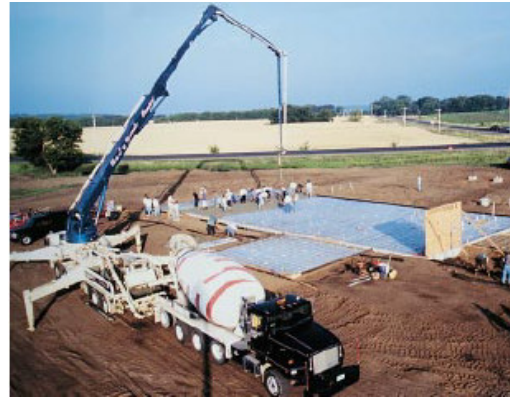
Fig. 10-15. (Izquierda) Una bomba montada sobre el camión y un aguilón pueden convenientemente mover el concreto verticalmente y horizontalmente para la posición deseada. (Derecha) Vista de la descarga del concreto de una manguera flexible conectada a la tubería rígida que se dirige de la bomba. La pipa (tubo) se usa en los aguilones de bombeo para mover el concreto hasta distancias relativamente largas. Hasta 8 m (25 pies) de manguera flexible se puede conectar a la extremidad de la tubería rígida para mejorar la movilidad de colocación.
